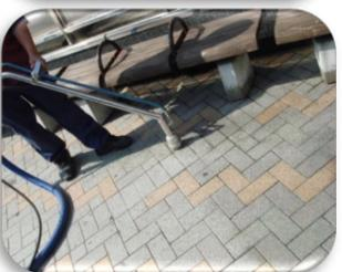
マンションの外周は高圧洗浄だと飛散したり噴射の跡が残るのが問題でしたが、斑が少なく飛散させずに作業が可能です。また、溶剤を極力使わずガム取りが出来ます。シミがでかないので全体を洗浄しても斑になることがありません。
