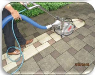
インターロッキングは高圧洗浄を行うと目地の砂やコケが飛散し後処理が大変でした。当機材は飛散が無いため効率良く作業が可能です。また、ウッドデッキは薬品で、あく抜きをするしかありませんでしたが、高温高圧をかけることで表面の皮が一枚めくれたような仕上がりが期待できます。
